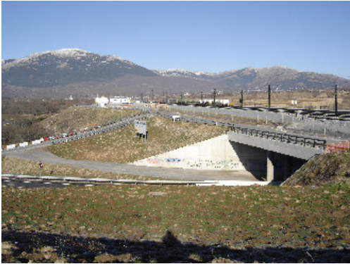
Fotografía 1. Restauración Túnel de Guadarrama.
