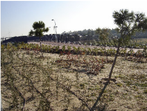
Fotografía 5. Obra de Jardinería Anillo verde, Madrid.
