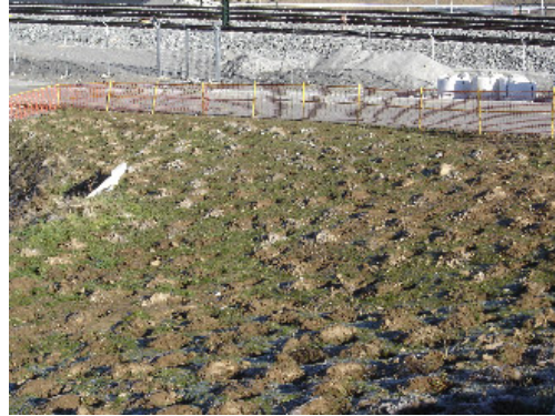
Fotografía 2. Hidrosiembra Túnel de Guadarrama.
