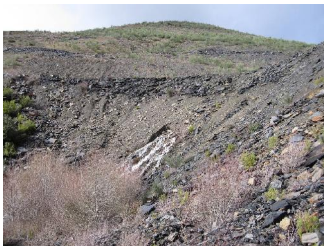
Figura 25. Erosión remontante en el afloramiento de las aguas del arroyo Fuente Lamocos.
