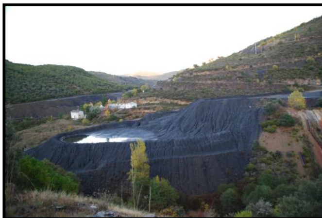
Figura 13. Vista de la zona de lavadero (FAB_FAB_05 a).
