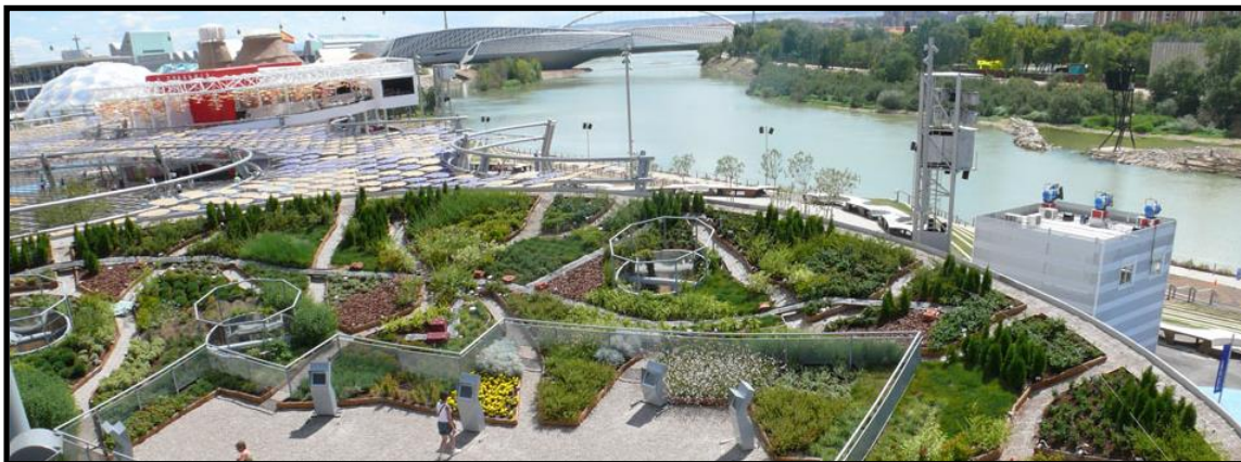
Figura 6. Techo verde semi-extensivo del Pabellón 6 del Parque Expo de Zaragoza (España).
