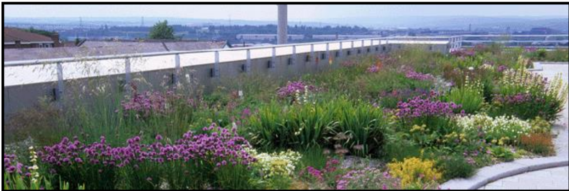
Figura 3. Techo verde semi-extensivo del Moorgate Crofts Business Centre de Rotherham, Reino Unido.
