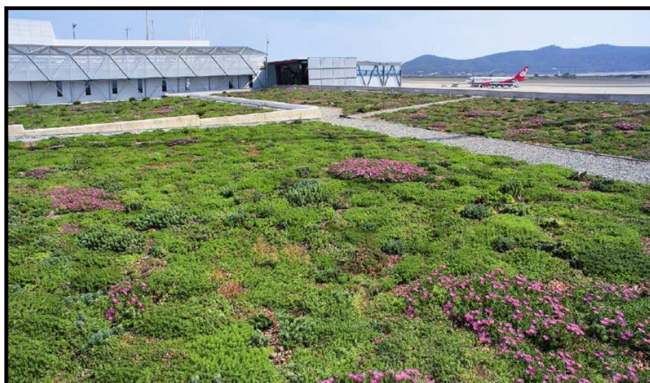
Figura 7. Techo verde extensivo del aeropuerto de Ibiza (España).
